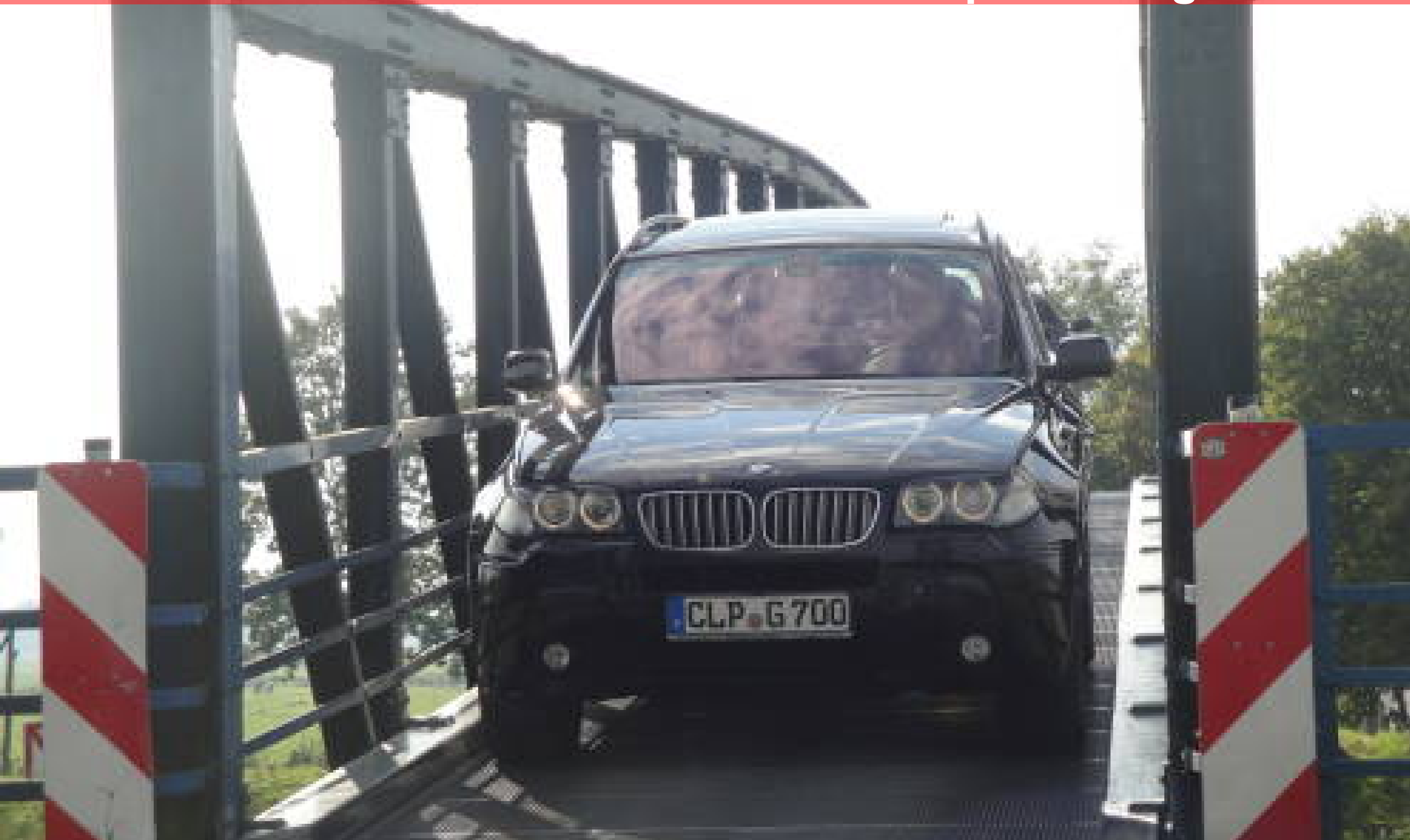
Amdorf - schmalste Brücke in Deutschland, Ostfriesland
